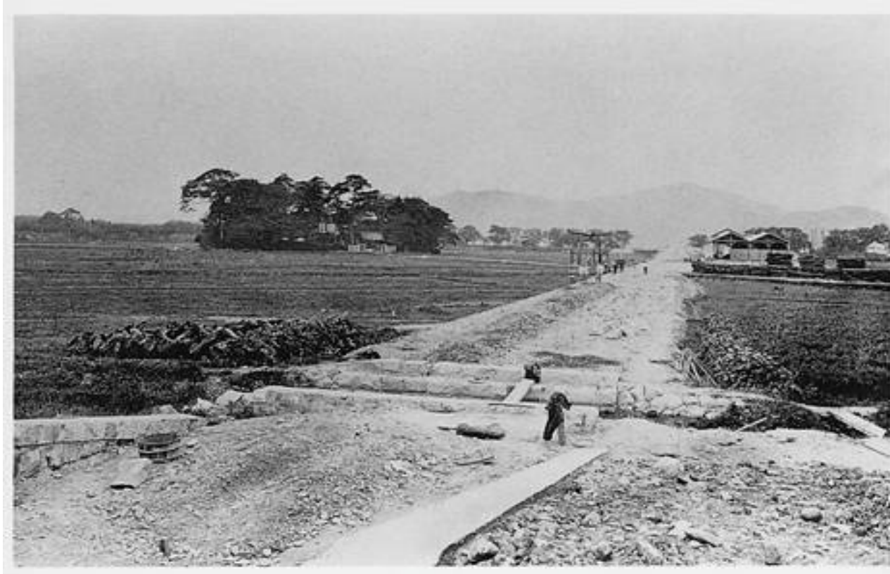
池田付近の線路敷設工事（1909年）
